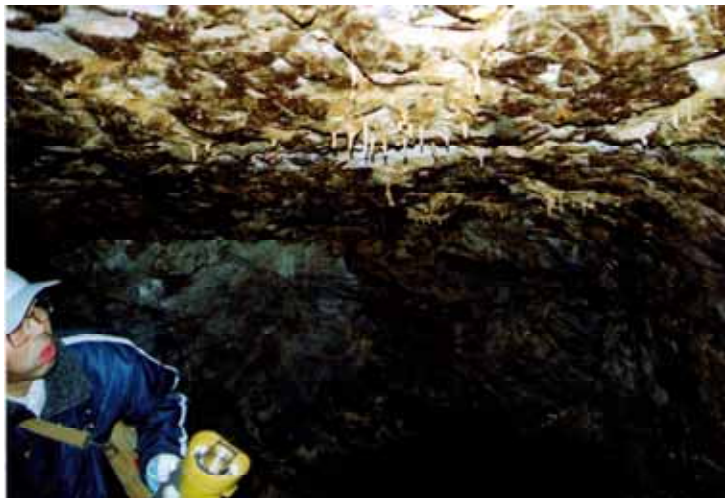
写真1 穴堰の天井に形成されていた鍾乳石
