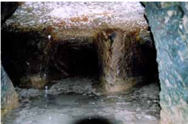
写真5 地下部分の分岐
