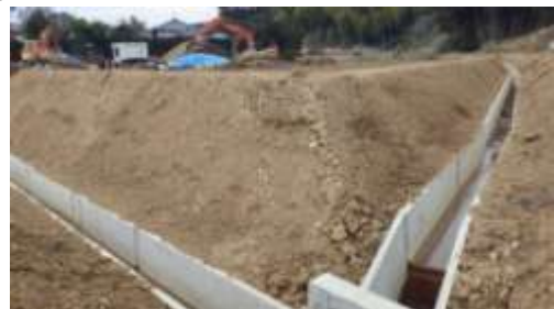
整備工事後の水田水路
